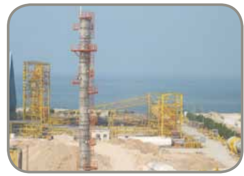
نمای کلی از اسکلت فلزی واحد اوره
